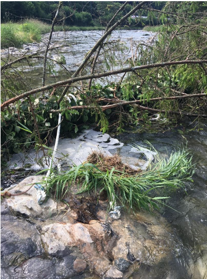
Abbildung 7: Befestigung der Raubaumbühne. Die Stämme wurden rund 6m weit ins Ufer eingegraben und mit einem 5m langen Stamm als «Toter Mann» rückgesichert
