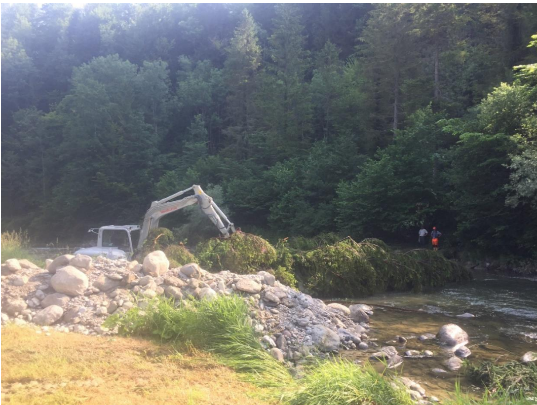
Abbildung 15: Setzen der Raubäume für die obere Stammuhne
