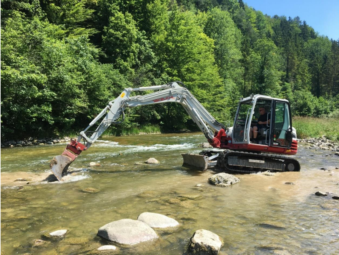
Abbildung 14: Vorarbeiten bei der unteren Stammuhne
