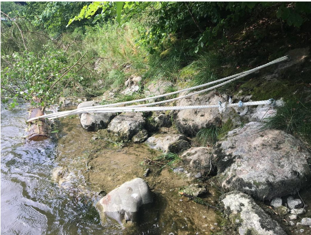
Abbildung 5: Befestigung des Raubaums
