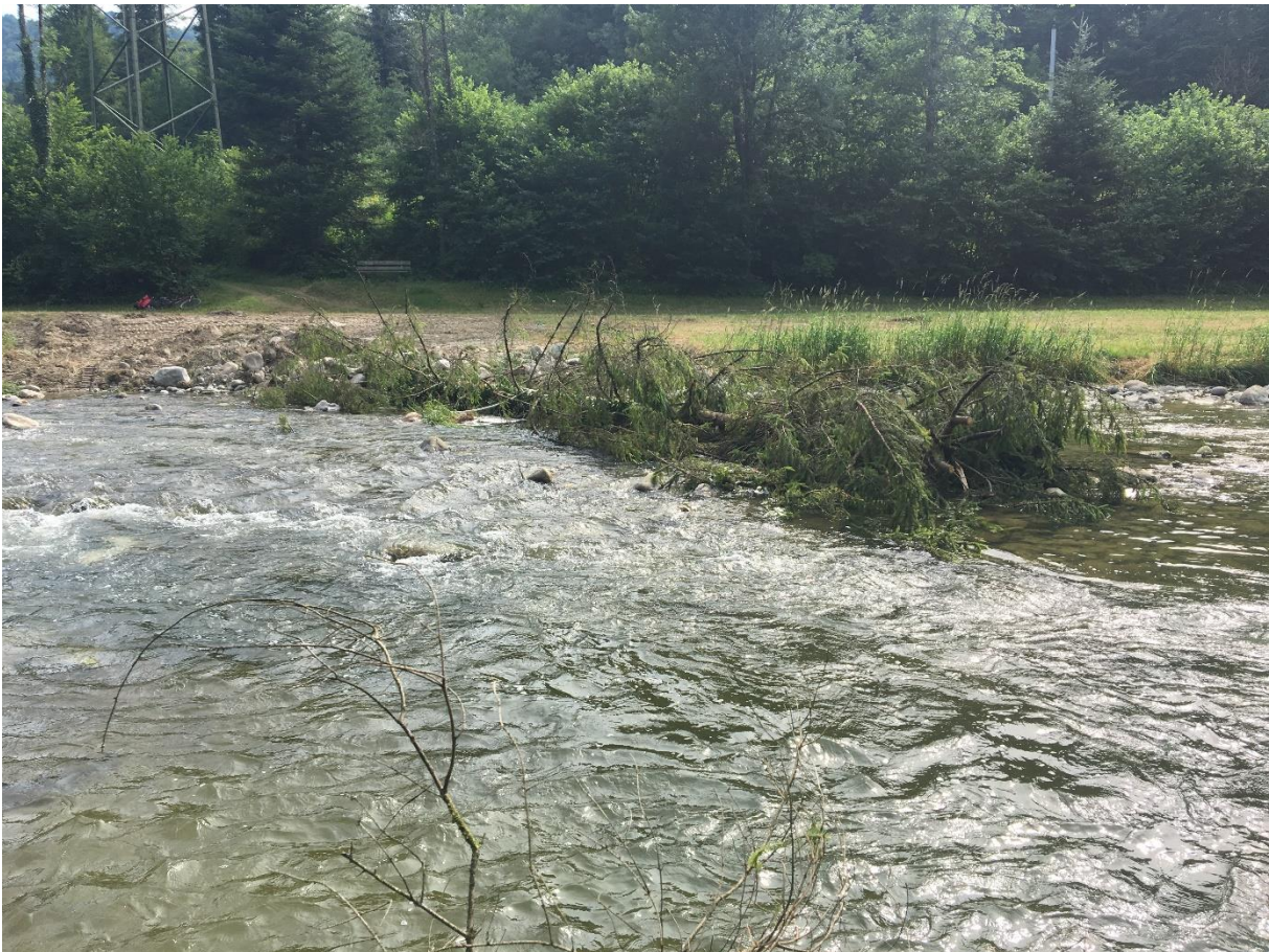
Abbildung 3: Die weit in die Gewässermittle ragende Buhne bündelt die Strömung markant
