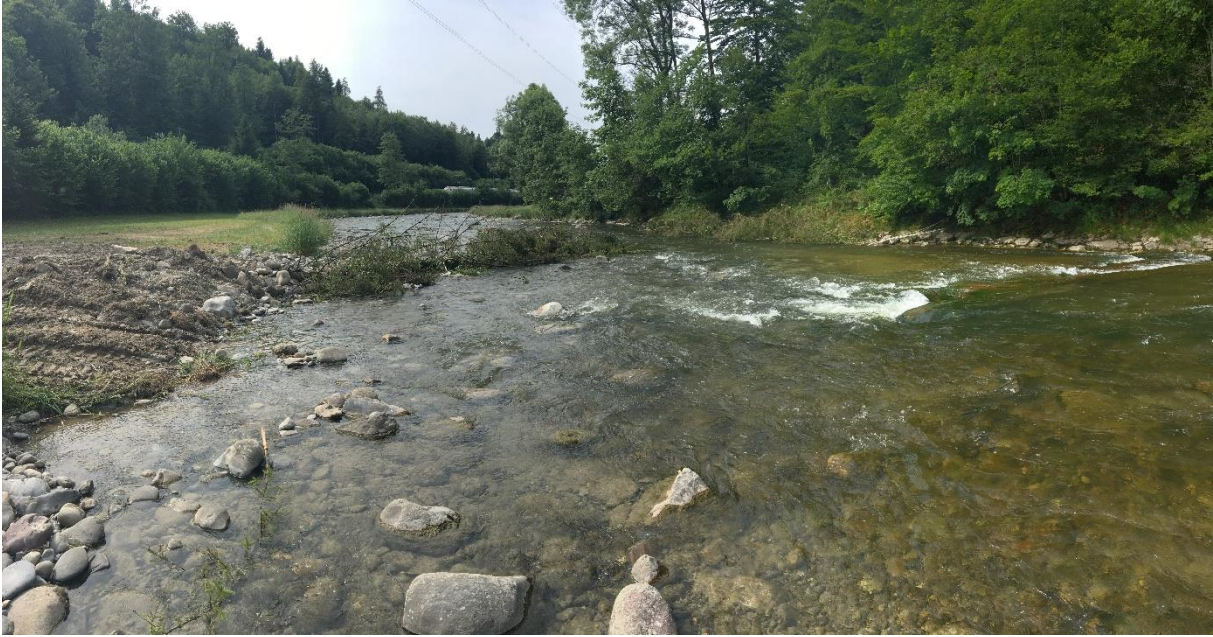
Abbildung 2: Nach dem Einbau.
