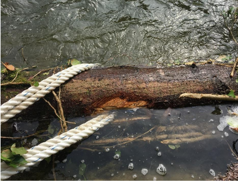
Abbildung 6: Mit Säge durchstochener Raubaum
