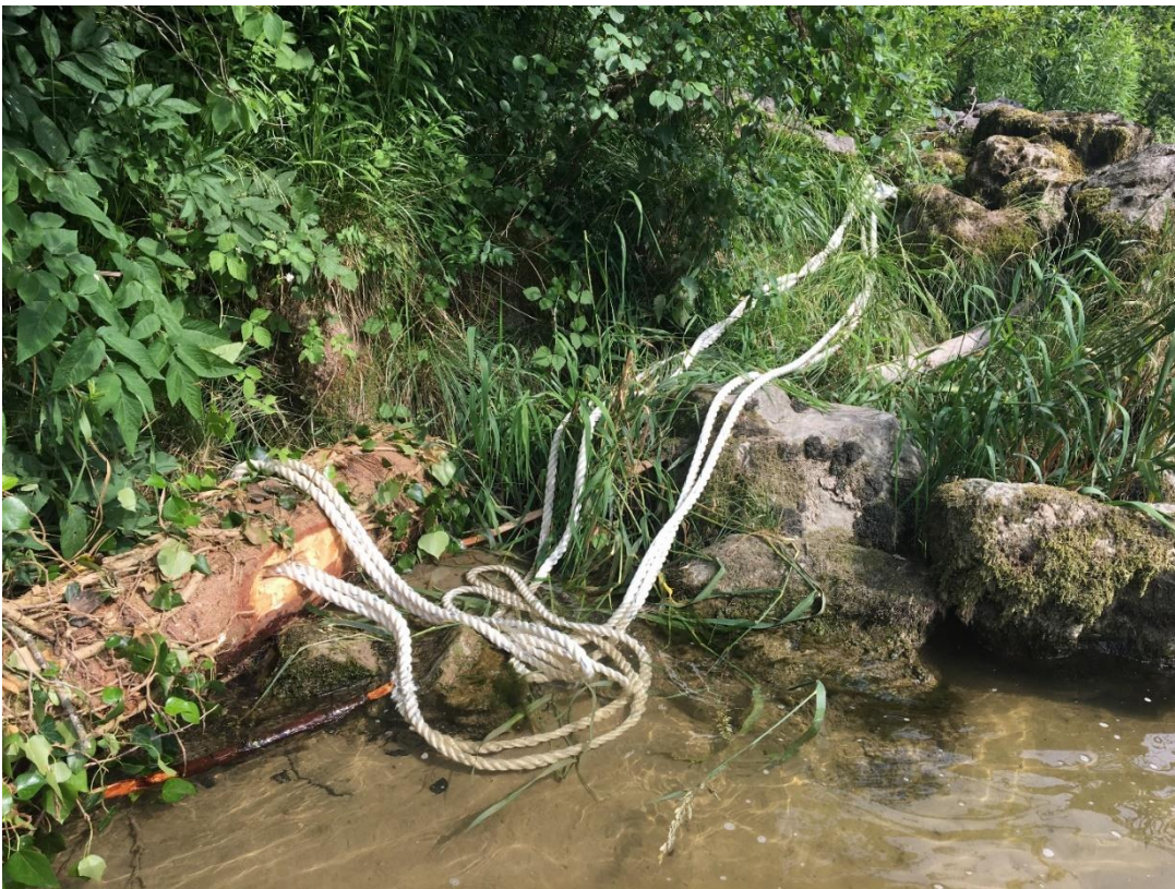
Abbildung 13: Befestigung des Raubaums an einem langen Seil. Bei Hochwasser wird sich der Standort des Raubaums verändern
